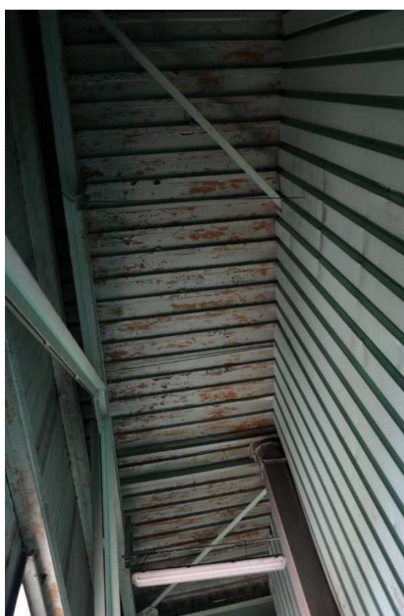
Klatka schodowa – dach.
